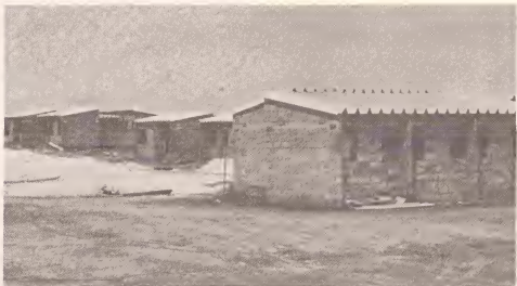
Casnan di pueblo den construccion.
